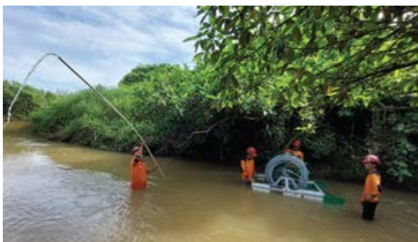
→ Tim EHS melakukan pemasangan sistem irigasi bebas emisi untuk mengembangkan program Tani Mandiri di ANJA
