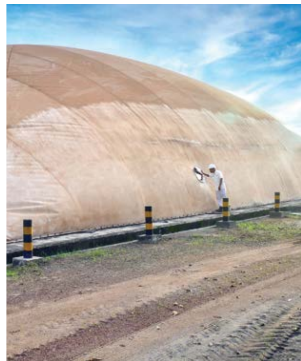
→ Seorang pekerja sedang memeriksa kondisi kubah biogas
